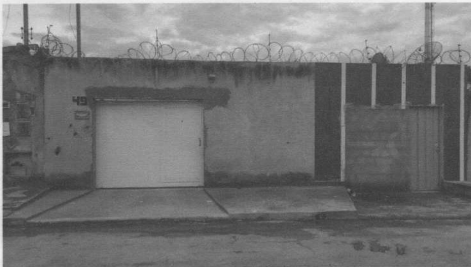
1.1 Fachada do imóvel pela rua.
