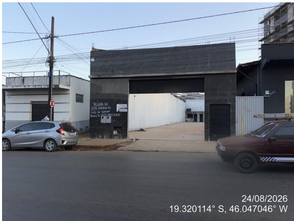
Figura 01: Fachada Principal do Galpão;
